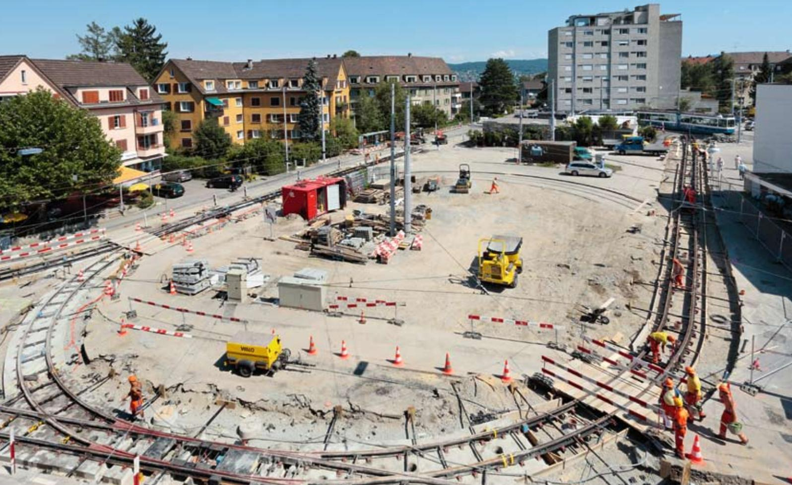
Im Zuge der Neugestaltung der Endhaltestelle Wollishofen wurden die 80 Jahre alten Tramgleise erneuert und gleichzeitig die Wasser- und Abwasserleitungen saniert.
